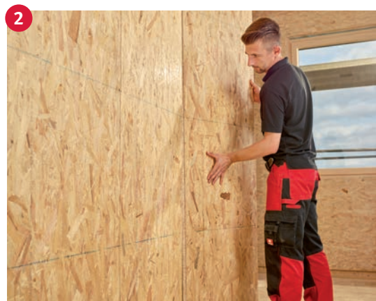
Foga ihop shi lap-fogen så kommer den andra panelen att hållas i sin position.
