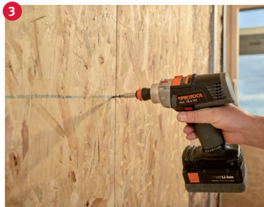
Fäst Ergo Boarden med 150 mm mellanrum.
